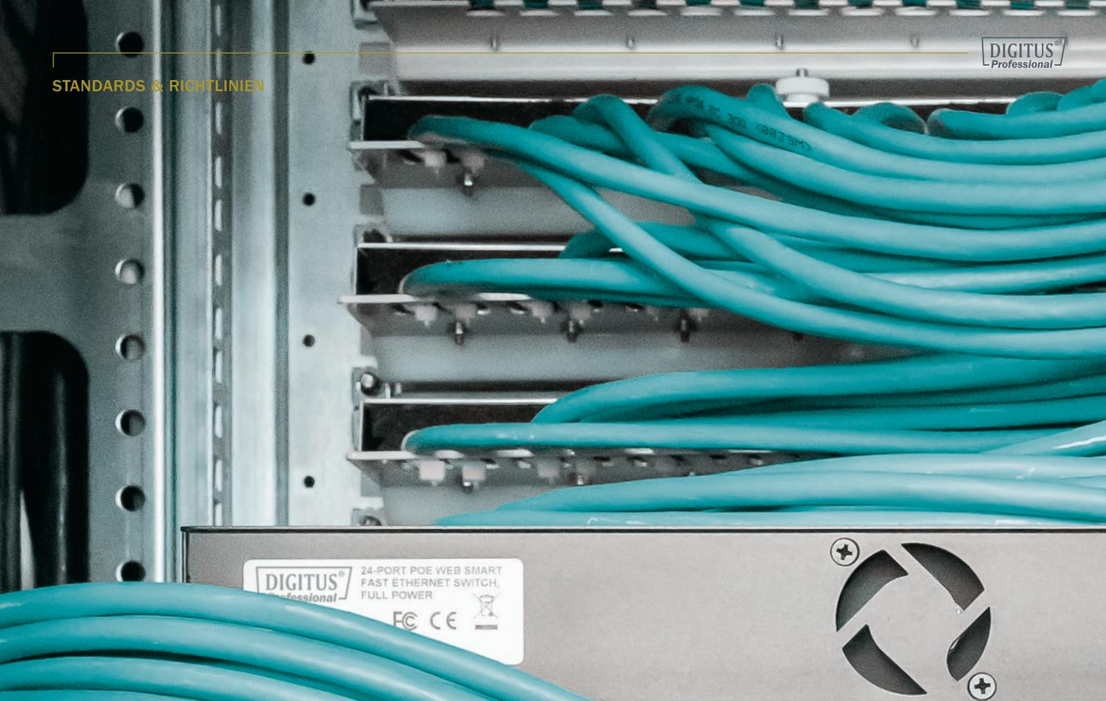
Die Bauproduktenverordnung bezieht sich „nur“ auf die „fest verlegte/installierte Infrastruktur“, enthält also keine Anschlusskomponenten oder Rangierkabel und auch keine Kompaktmodule. Es werden jedoch alle vorkonfektionierten Lösungen wie zum Beispiel Glasfaser-/Kupfer-Trunkkabel die als „fest installiert“ gelten abgedeckt, wobei diese jedoch auf die Massenkabel-Zertifizierung angewiesen sind, auf welcher die Baugruppe aufgebaut wurde.
